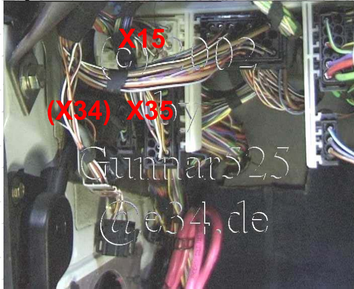
Abbildung 13: Kabelende Temperaturfühlers links neben der Lenksäule
